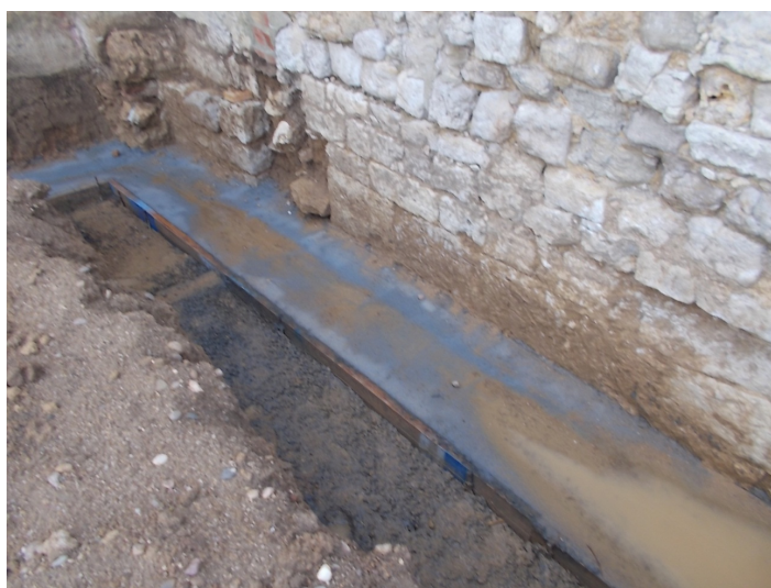
Construcción de la cámara bufa
